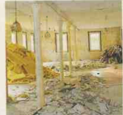
Im Obergeschoss des Gebäudes entsteht ein Schlafraum.
